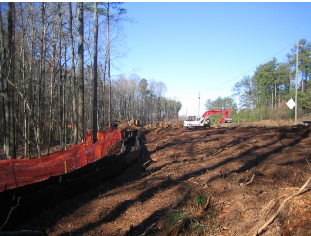
Barreras de protección de los arboles y barreras de limo instalados bien al sitio de cosecha de madera.
