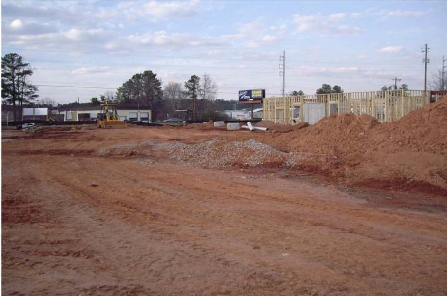
*Fig. 3 El movimiento de equipo pesado sobre el terreno durante construcción puede compactar el terreno profundamente. Este tipo de compactación debe ser corregida antes de plantar o los arboles tendran mayor tendencia a desarrollarraices superficiales y ser mas suceptibles a estres humedad.*
